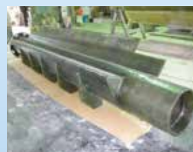
タンク製作／現地補修
